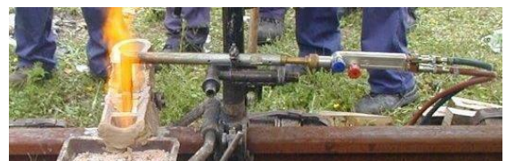
Slika 6 - Predzagrevanje kalupa
