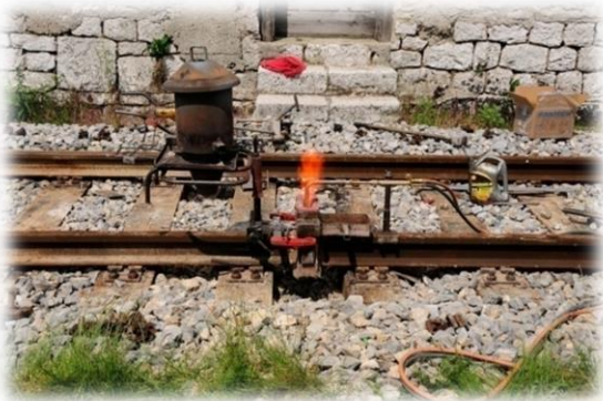
Slika 16 - Aluminotremijska reakcija u loncu
