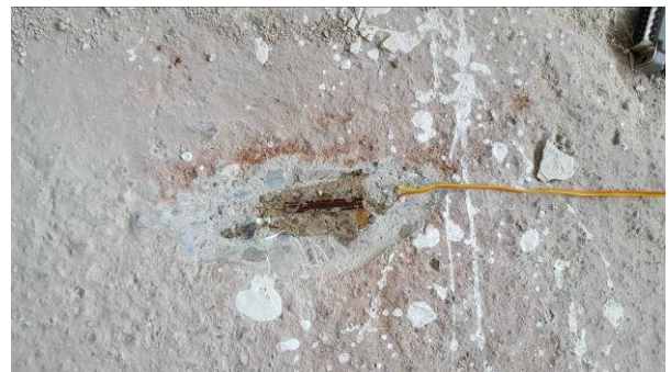
Slika 4 – Položaj merne trake u pritisnutoj zoni betonske ploče (MT 4)
