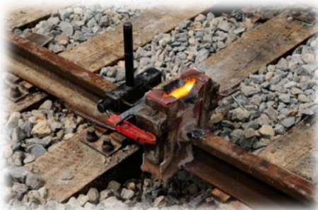
Slika 18- Izgled kalupa nakon izlivanja čelika
