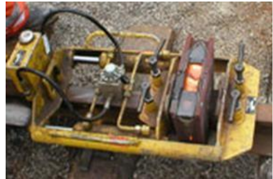
Slika 19 - Hidrauličko uklanjanje kalupa i viška materijala
