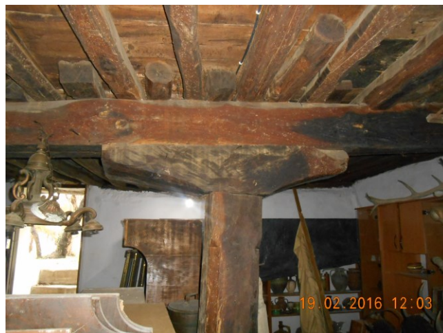
Slika 2 –Deterioracija neadekvatno zaštićene drvene međuspratne konstrukcije usled bioloških uticaja
