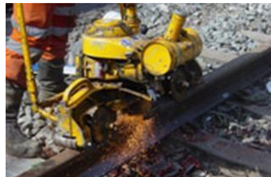
Slika 20 - Završno brušenje šina
