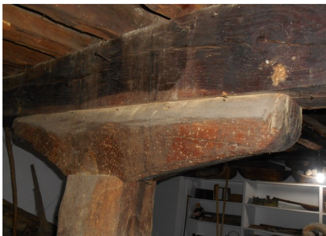
Slika 2 –Deterioracija neadekvatno zaštićene drvene međuspratne konstrukcije usled bioloških uticaja
