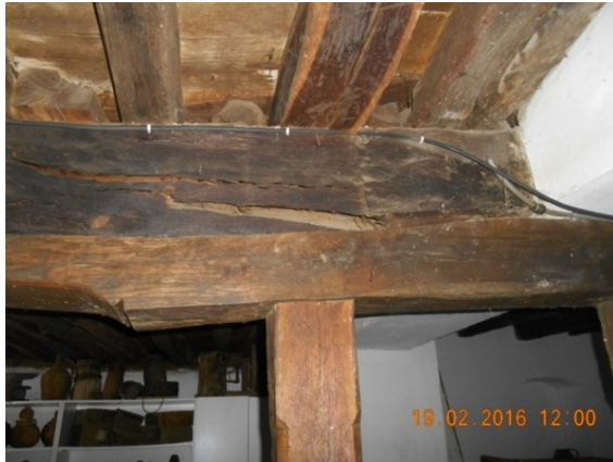
Slika 4 – Oštećenja centralne, noseće grede MSK
