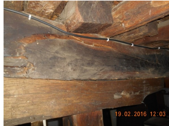
Slika 4 – Oštećenja centralne, noseće grede MSK
