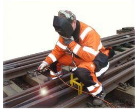
Slika 27 - Prikazan je postupak elektrolučnog zavarivanja
